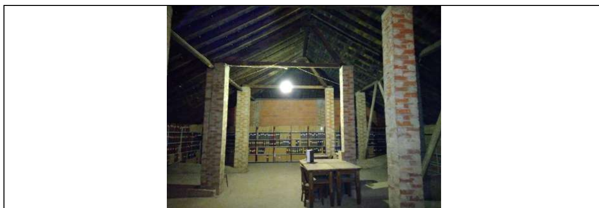
Fotografia da visita realizada – vista do interior da cobertura do edifício principal
