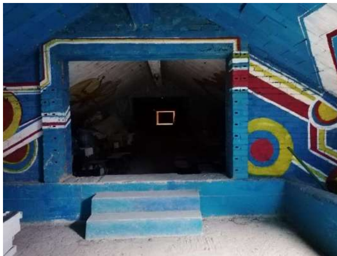
Cobertura com vigas invertidas na laje de esteira
