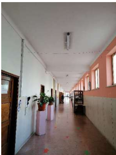
Corredor no terceiro com vigas aparentes
