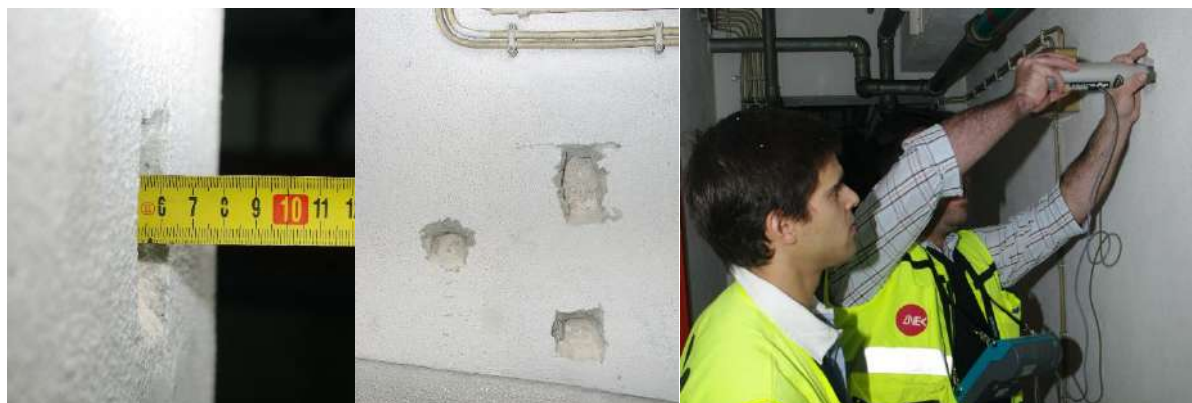
Figura 6.8 – Medições de recobrimento (esq.); abertura de janelas em pilares e paredes (centro); medição com esclerómetro em pilares e paredes resistentes (dir.)
