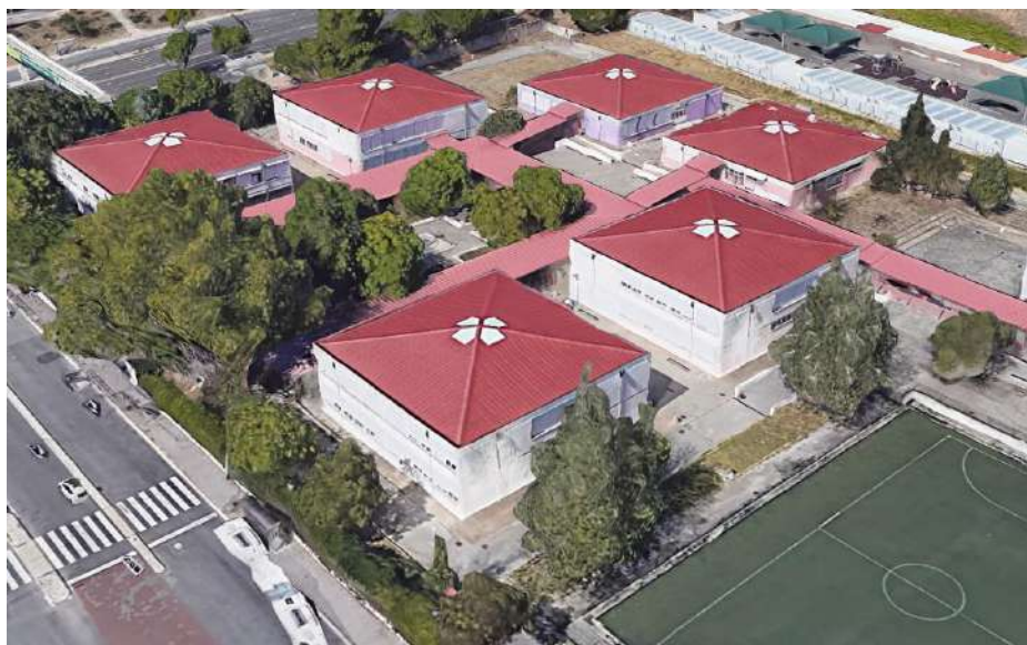
Figura 3.4 – Escola secundária do Restelo (tipologia pavilhonar 3x3)
