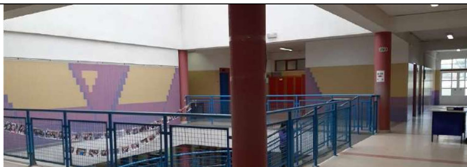
Fotografias da visita à escola: zona de escadas do bloco CC com pilares circulares e vigas aparentes
