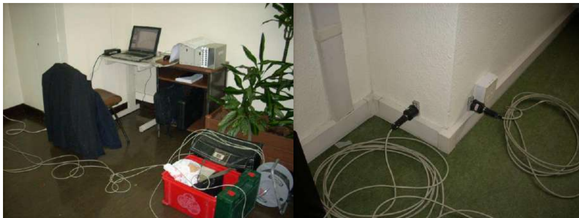
Figura 6.10 – Sistema de aquisição de dados em ensaio de identificação dinâmica (esq.); vista de dois acelerómetros num pilar, para uma das configurações de ensaio (dir.)
