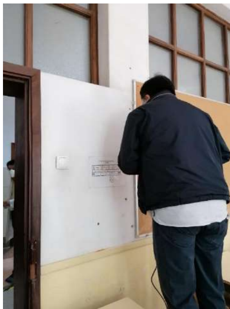
Figura 3.9 – Furação com berbequim na EB23 Eugénio dos Santos para caracterização de pormenores construtivos das paredes interiores (ligação de painel de alvenaria de tijolo a montantes em betão)
