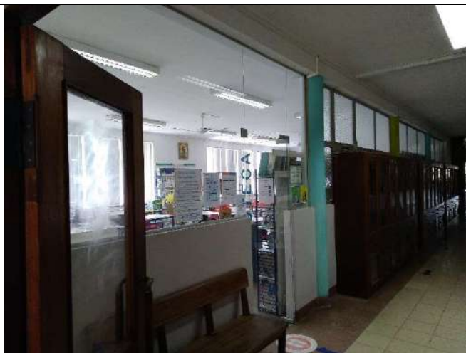
Fotografia da visita à escola – alinhamento do corredor central com pilares circulares e viga; parede exteriores em alvenaria
