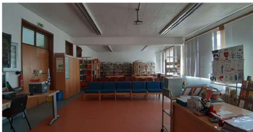
Fotografia da zona de biblioteca com viga aparente no alinhamento central do bloco
