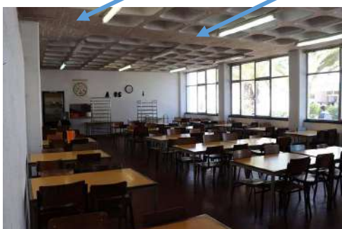
Blocos com laje fungiforme, com zonas amaciçadas na envoltura e nos alinhamentos entre pilares: bloco refeição (esq.); bloco D (dir.)
