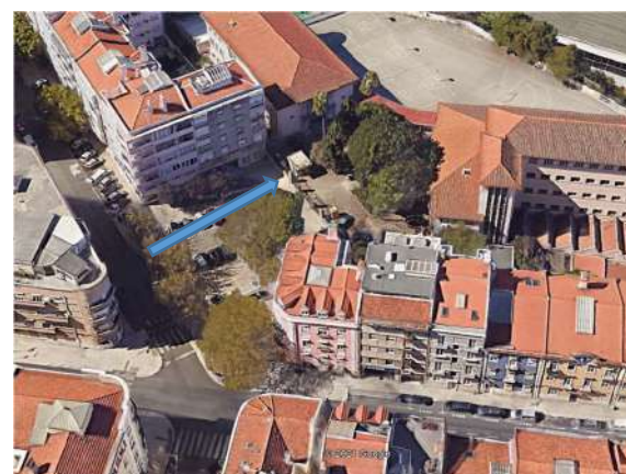
Imagem aérea da entrada da escola, através de praça
