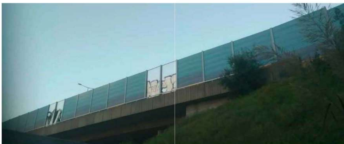
Figura 6: Apontamento fotográfico da barreira acústica existente no local
