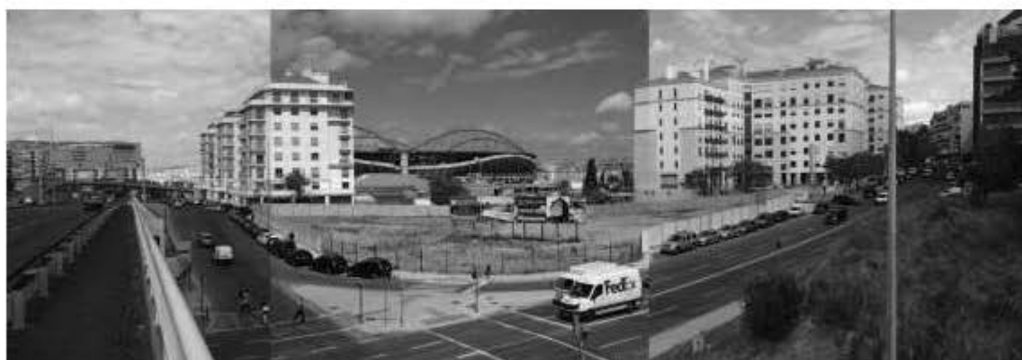
Foto: O lote 10 em primeiro plano, visto de sul a partir do viaduto da Avenida Lusíada.
