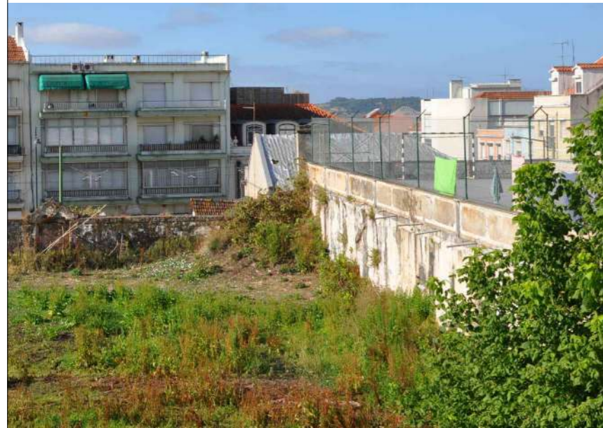
4.3/5.3 Vista da cobertura a partir do terraço da Escola da Voz do Operário
