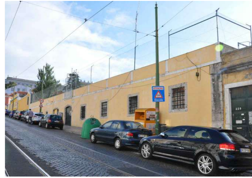
4.2/5.2 Vista da fachada Poente - Calçada da Ajuda (2)
