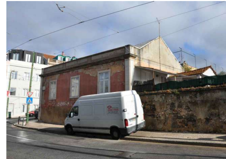
6.4 Vista das fachadas Sul e Nascente - Rua Bica do Marquês
