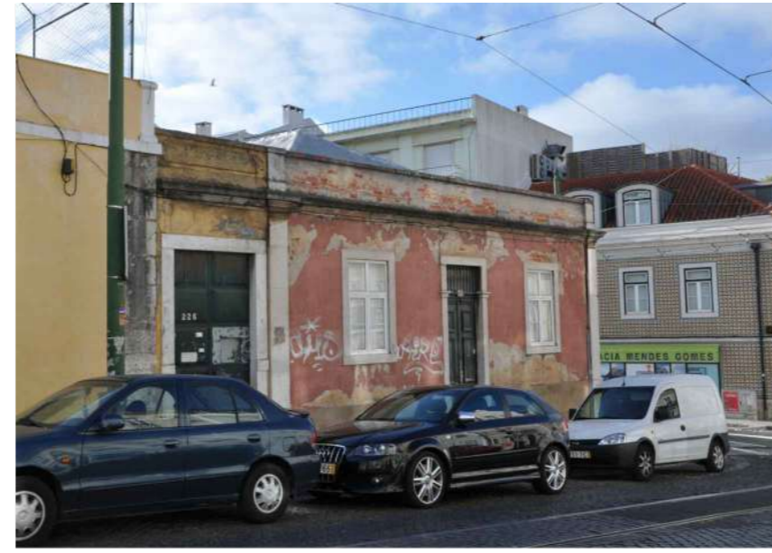
6.1 Vista da fachada Poente - Calçada da Ajuda
