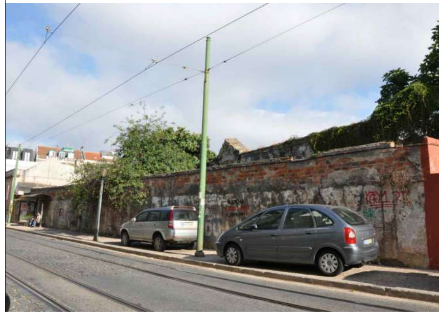
7.1/8.1 Vista do lado Sul do muro - Rua Bica do Marquês
