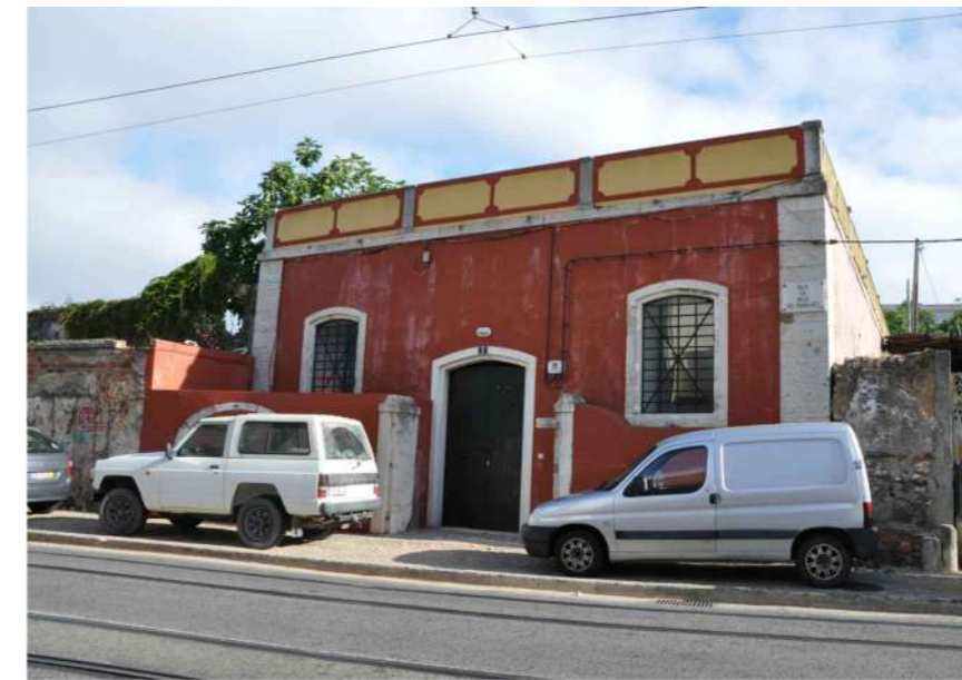
9.2 Vista da fachada Sul - Rua Bica do Marquês (2)
