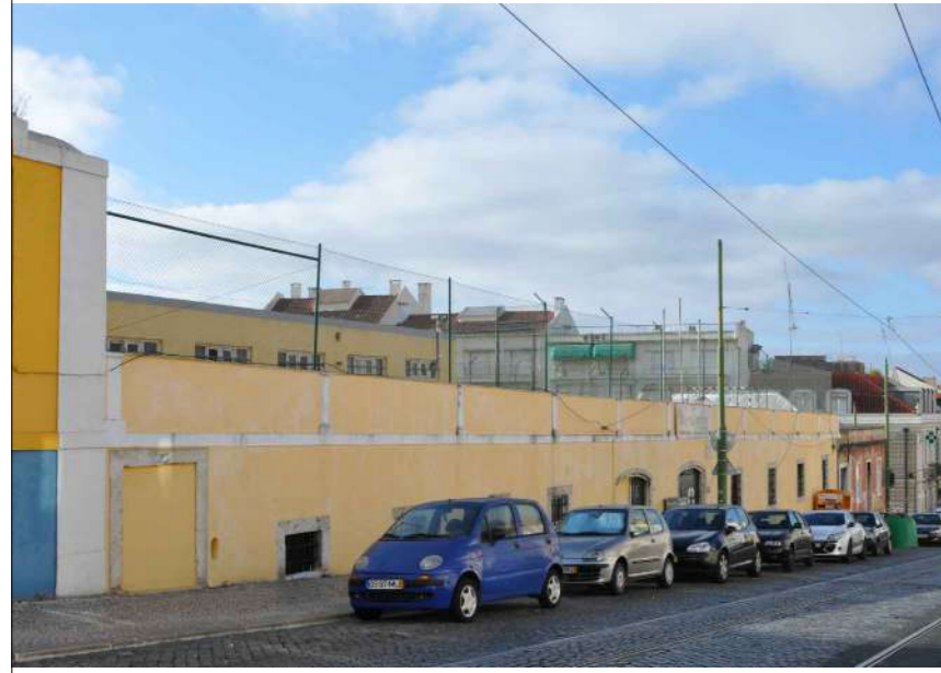
4.1/5.1 Vista da fachada Poente - Calçada da Ajuda
