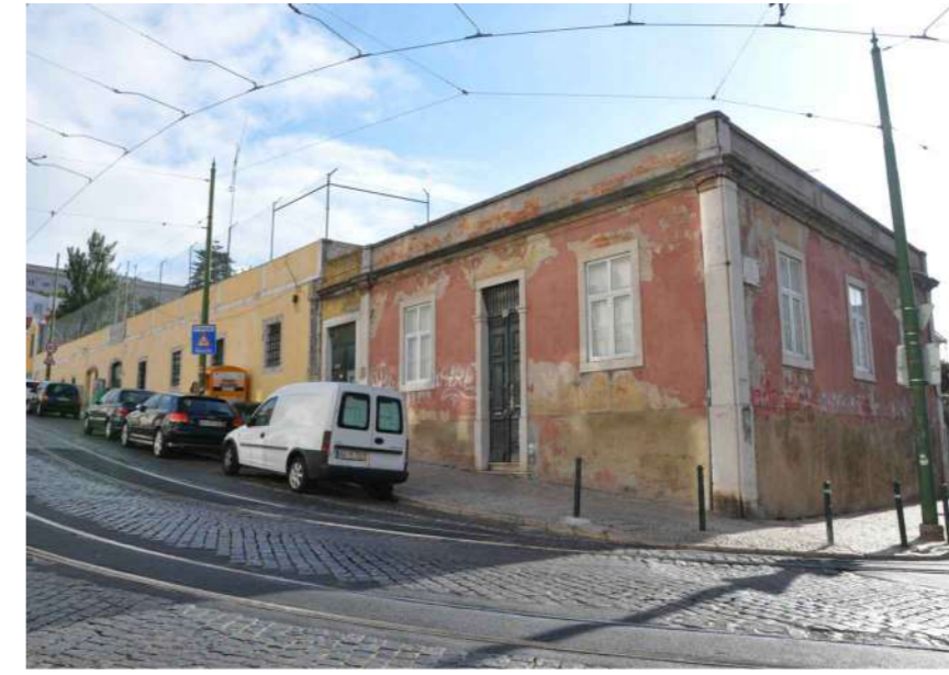
6.2 Vista das fachadas Poente e Sul - Calçada da Ajuda
