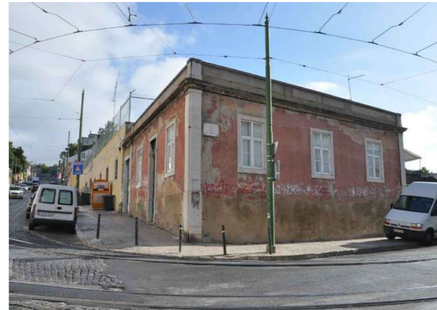
6.3 Vista das fachadas Poente e Sul - cruzamento Calçada da Ajuda com a Rua Bica do Marquês
