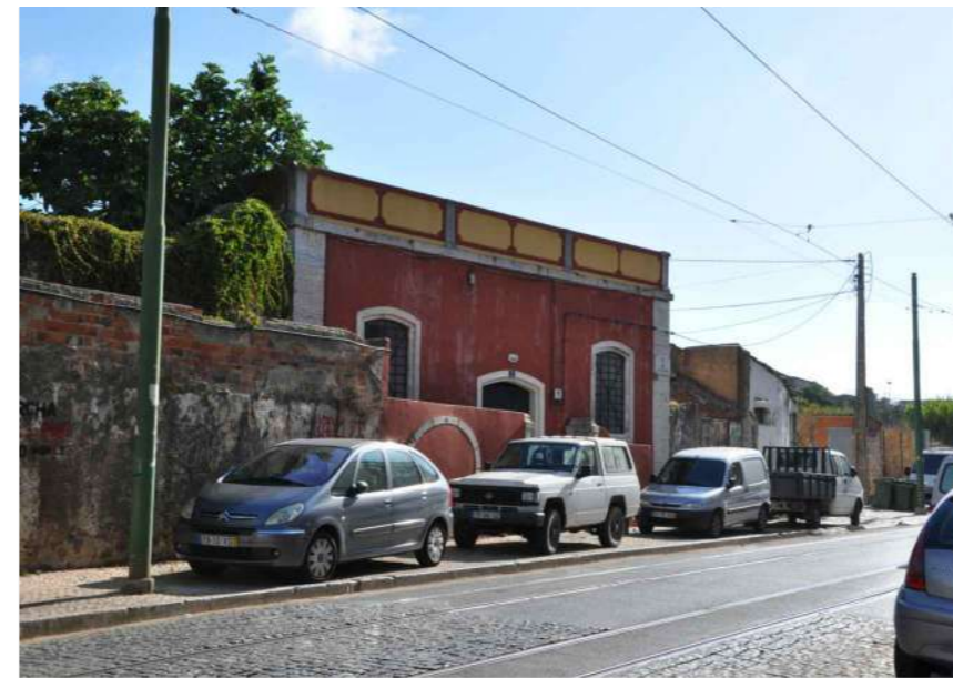
9.1 Vista da fachada Sul - Rua Bica do Marquês
