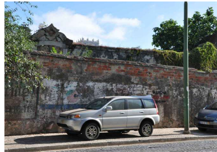
7.2/8.2 Vista do lado Sul do muro - Rua Bica do Marquês - Pormenor
