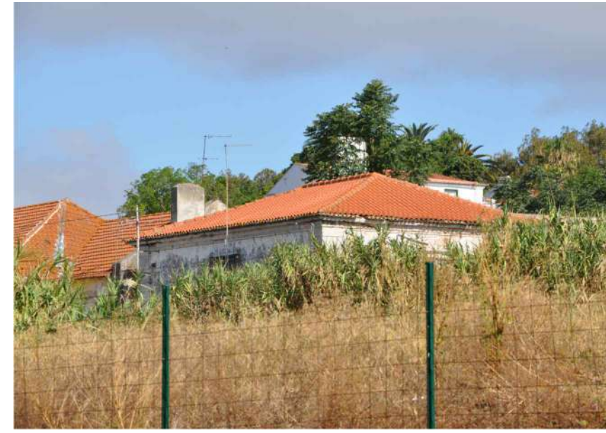
11.2 Vista das fachadas Sul e Nascente – Rua Bica do Marquês
