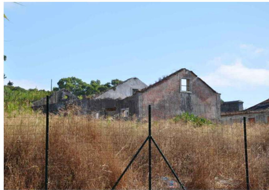
12.2 Vista fachadas Poente e Sul – Rua Bica do Marquês (2)
