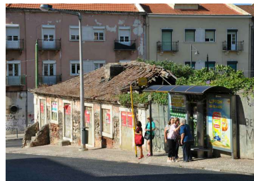
13.4 Vista das fachadas Nascente e Norte – Rua Dom Vasco
