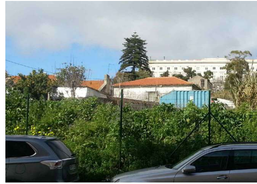
11.1 Vista fachada Sul – Rua Bica do Marquês
