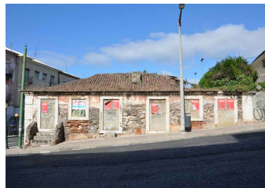
13.3 Vista da fachada Nascente – Rua Dom Vasco
