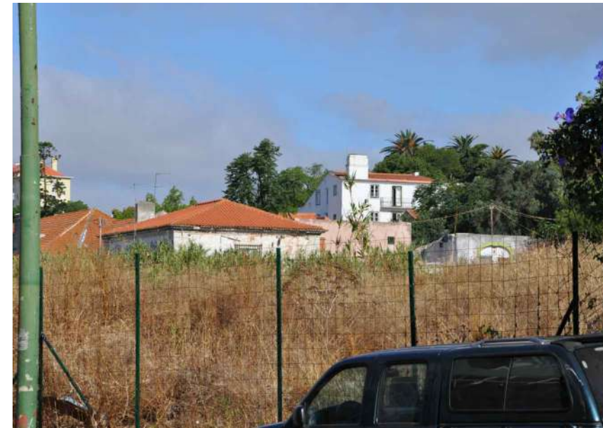
11.3 Vista das fachadas Sul e Nascente – Rua Bica do Marquês
