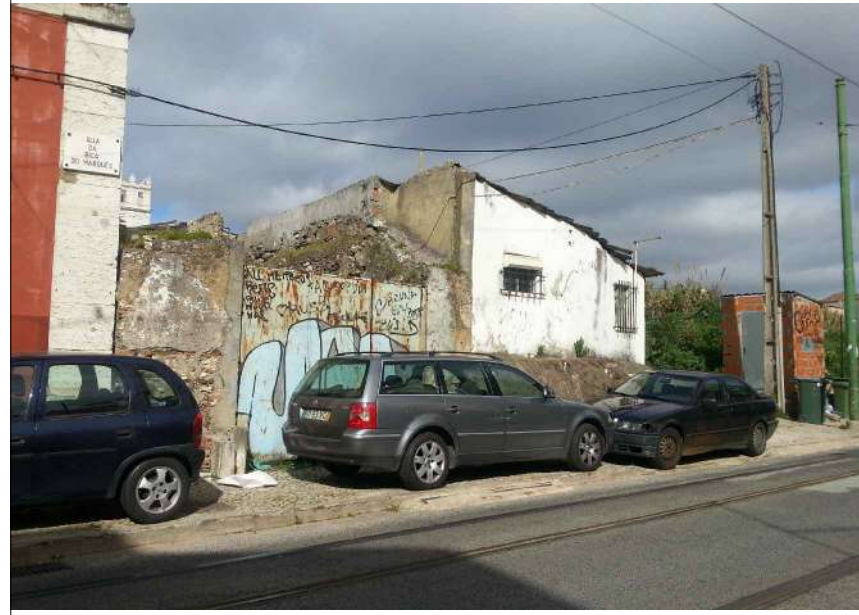
10.1 Vista das fachadas Poente e Sul – Rua Bica do Marquês
