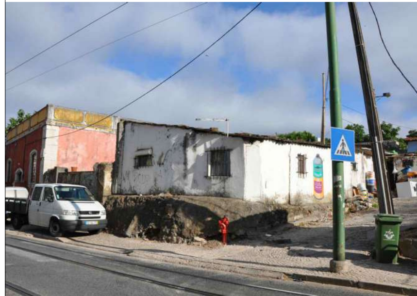
10.3 Vista das fachadas Sul e Nascente – Rua Bica do Marquês
