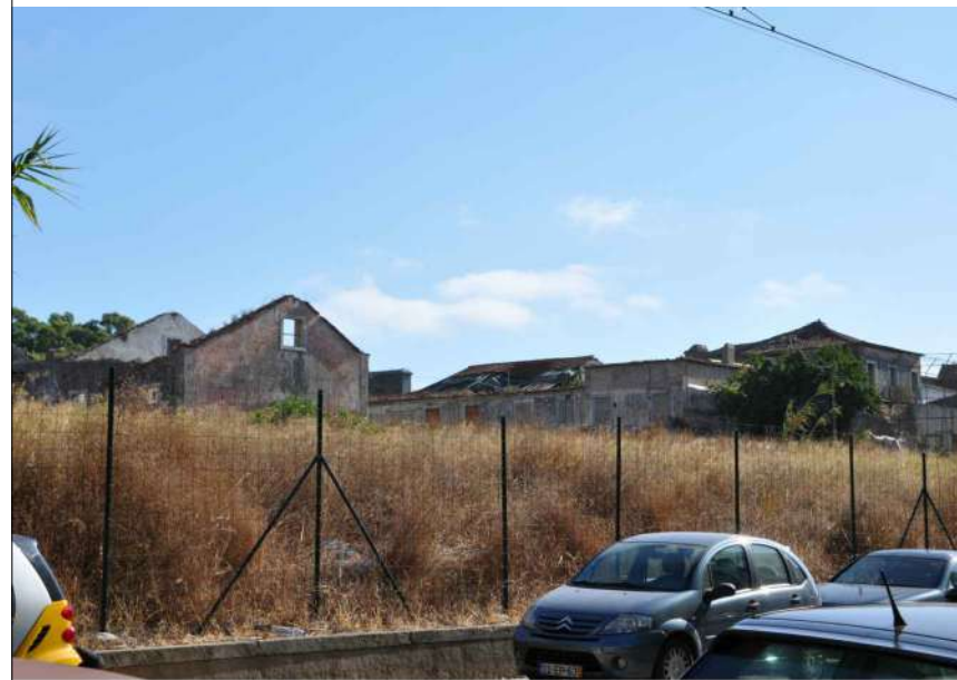
12.1 Vista fachadas Poente e Sul – Rua Bica do Marquês
