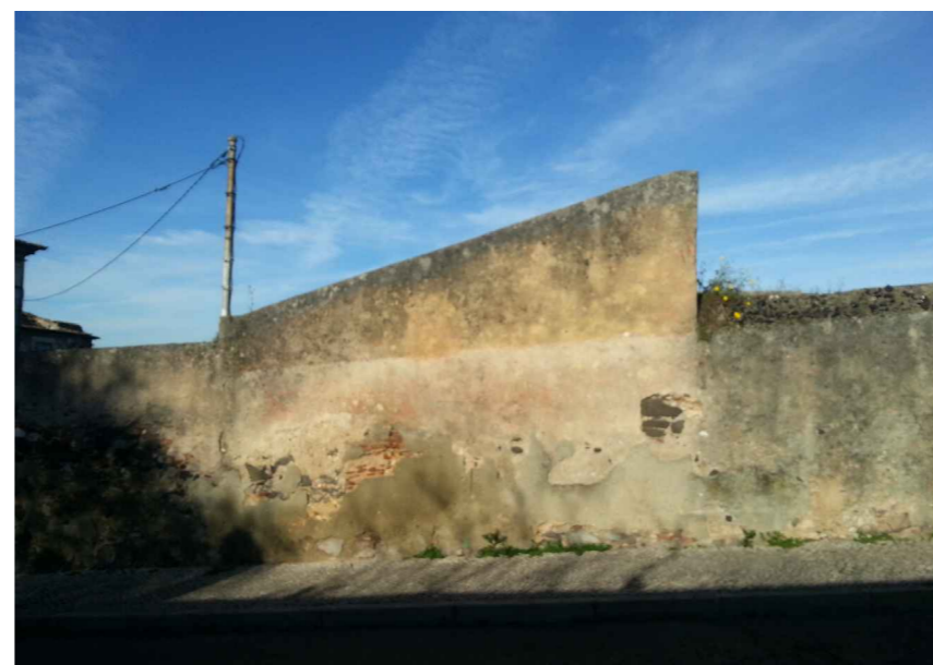
17.3 Vista da fachada Nascente - Rua Dom Vasco
