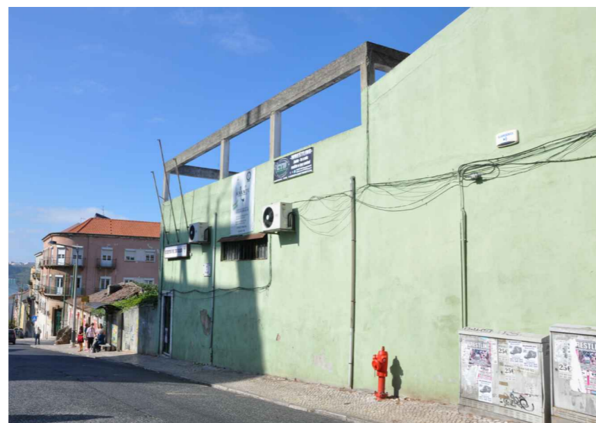
14.4 Vista da fachada Nascente - Rua Dom Vasco (3)
