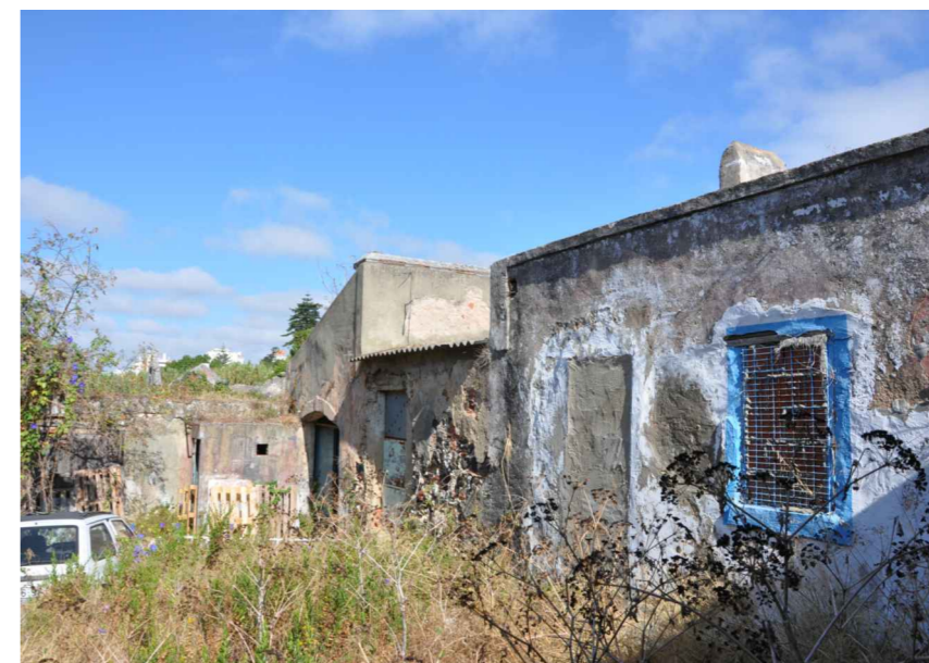
17.2 Vista da fachada Sul a partir do interior do Pátio das Damas
