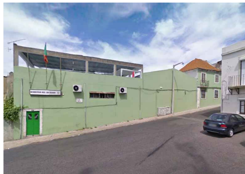
14.2 Vista da fachada Nascente - Rua Dom Vasco
