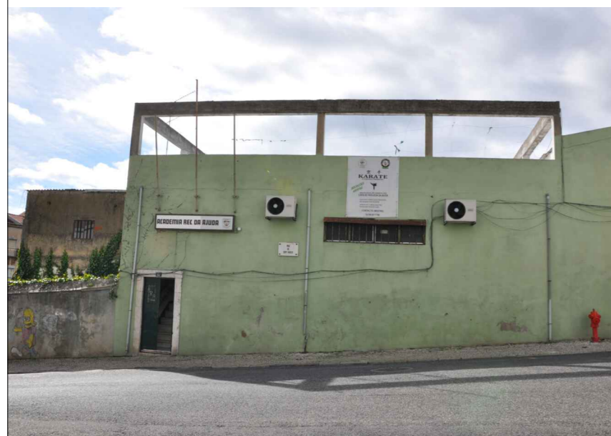
14.3 Vista da fachada Nascente - Rua Dom Vasco (2)
