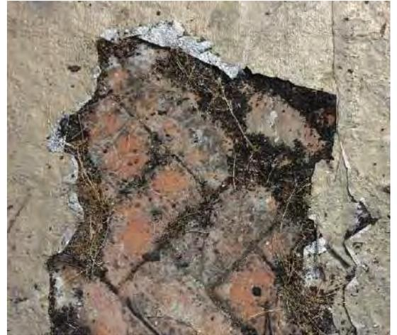
Figs. 24 e 25 - Aspeto do eirado, ou terraço, do armazém principal e pormenor de hipotético exemplo da tijoleira de revestimento original. Fonte: DPU/DPT
