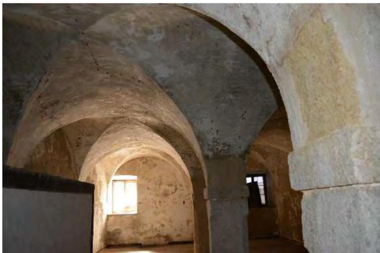
**Figs. 36, 37** – Espaço interior: pormenores arquitetónicos e construtivos (travejamento em madeira do soalho e abóbadas de aresta). Fonte: DPU/DPT
