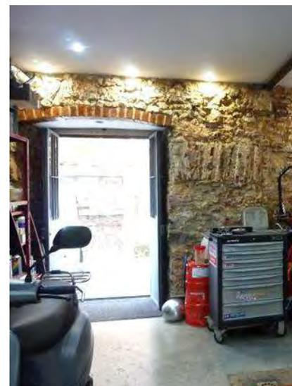
Fig. 22a, b, c – Aspeto atual do interior de um estabelecimento no piso térreo, ocupando toda a profundidade do lote: pilares de suporte em ferro; aspeto do sistema construtivo e da espessura da parede de tardo; aspeto da parede de tardo, com vestígios de vãos e indícios de pé-direitos anteriores. Fonte: DPU/DPT, out. 2018
