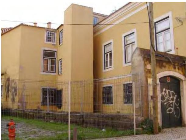
Fig. 9 - Pormenor da fachada virada a nascente. Destaca-se a torre do elevador, aposta em 1982 (Fonte: DPU/DPT)
