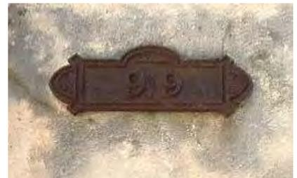
Figs. 47, 48 – Placa metálica com indicação altimétrica: 9,9. Fonte: DPU/DPT
